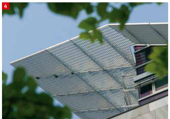
Lichtgitter Sonnenschutzroste sind ein modernes und vielseitiges Konstruktionselement. Die Wirkung des Sonnenschutzes ist dabei abhängig von der Höhe der parallel mit dem Gebäude verlaufenden Tragstäbe und deren Abstände untereinander.
